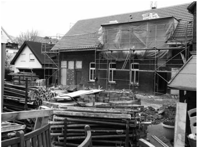
Noch eine große Baustelle ...
